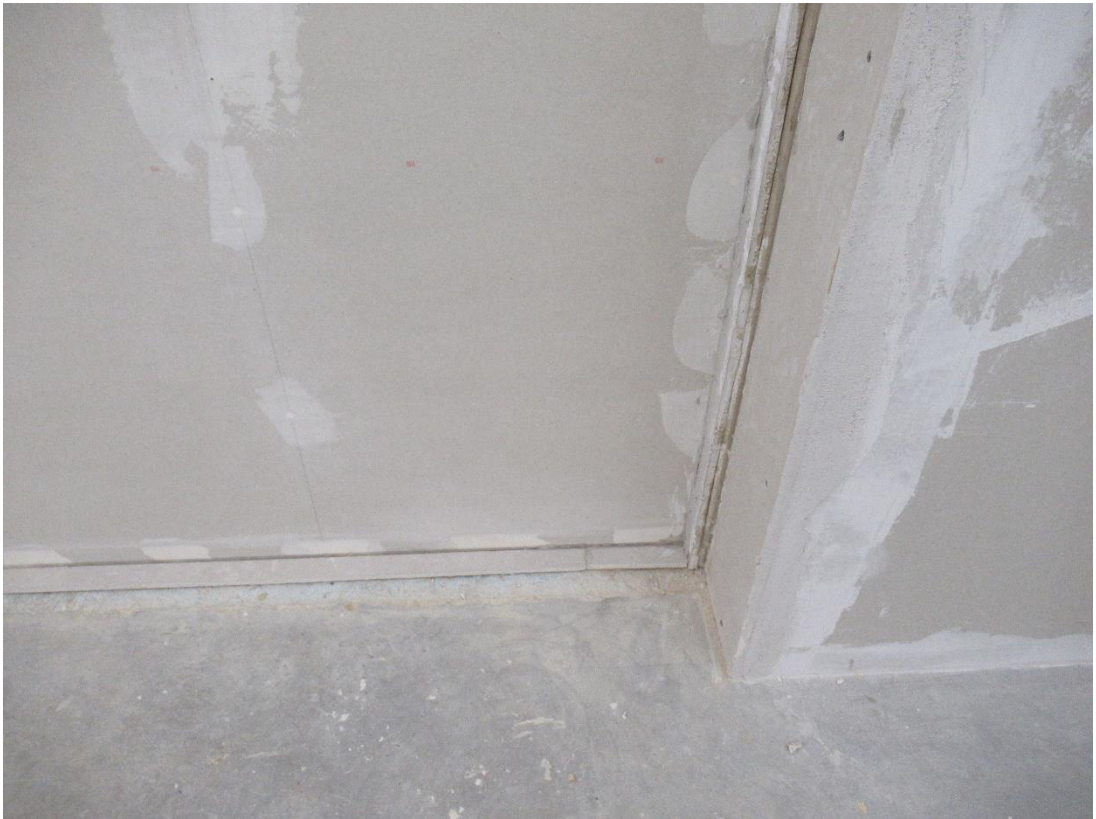
Bild 2: Trockenbauwand mit Gipskartonbauplatte (Referenzwand), Detail
