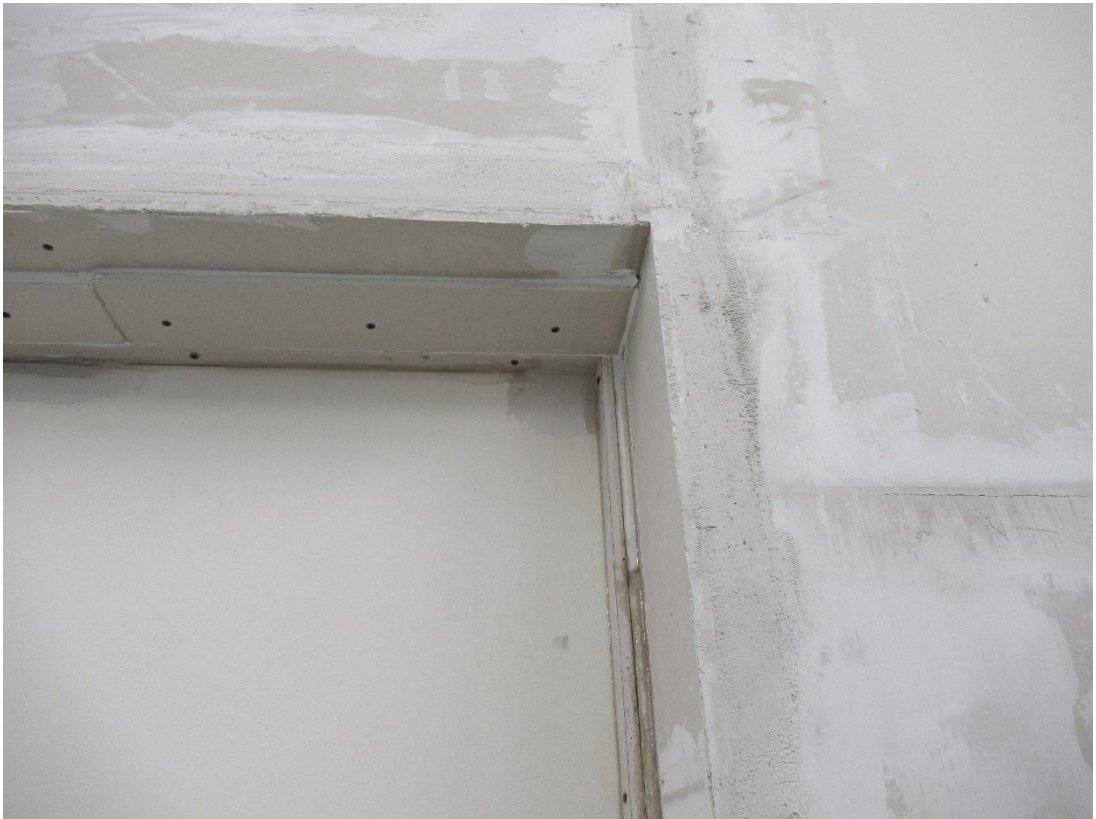
Bild 4: Trockenbauwand mit Lehmputz-Trockenbauplatte, Typ naturbo clima, Detail
