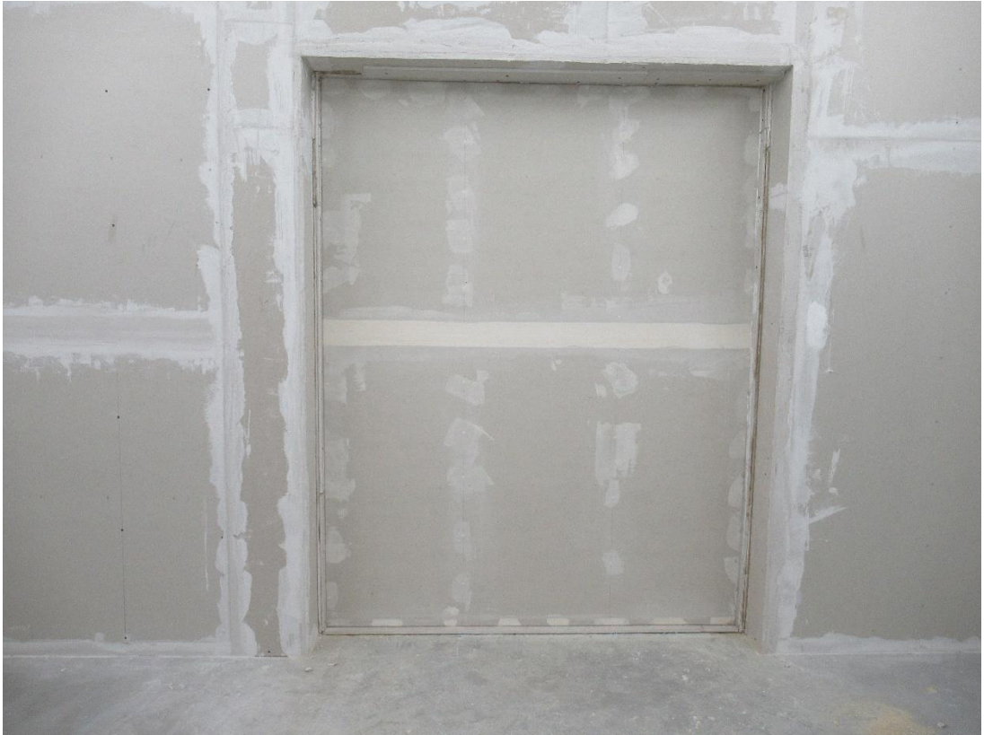
Bild 1: Trockenbauwand mit Gipskartonplatte (Referenzwand)
