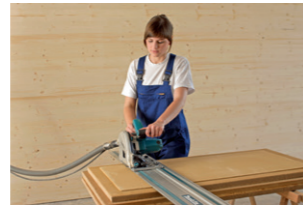
Zuschneiden der Platten
