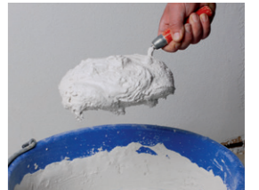
richtige Konsistenz des Lehm-Finishputz als Veredelungsschicht
