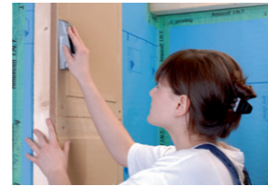
Einbringen der Flachkante
