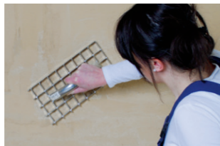
Fläche mit Lehmputz-Spezialrobot egalieren
