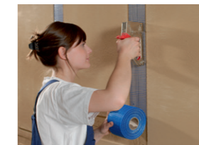
Fugenarmierungsgewebe in Flachkanten eintackern
