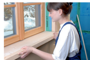
Fenstersims einsetzen
