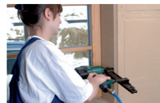
naturbo Windowsplatte montieren
