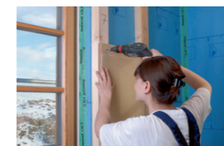
Anschlussplatte montieren
