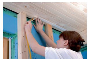
Dichtungsband/Trennlagenpapier ankleben
