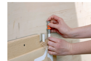
Presskupplung ganz aufsetzen
