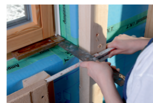
Anschlussplatte ausmessen
