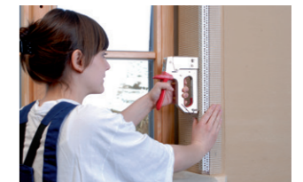
Eckwinkel montieren
